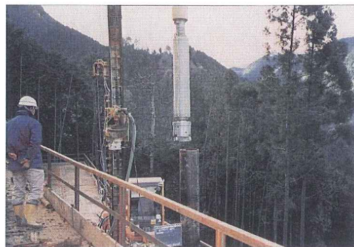
土留め杭 孔壁の崩壊防止ができ穿孔完了後、ハンマー、ビットを引き抜き、ケーシング内にH鋼やGパイルを建て込み後、ケーシングは回収されます。
